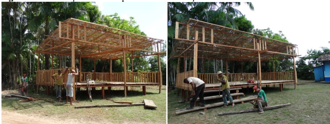
Figura 21. Construção do Palco para Festival do Açai
