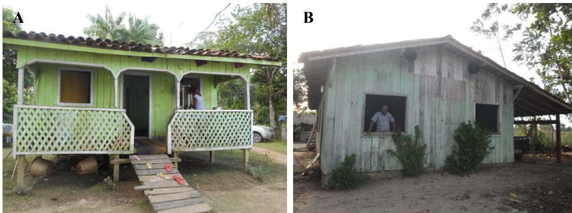
Figura 8. Localização das casas: A) Fachada da casa do seu Manoel Raulins a beira do Rio Capim. B) Fachada da casa do seu Zito, no ramal Urucuritêua, Centro.
