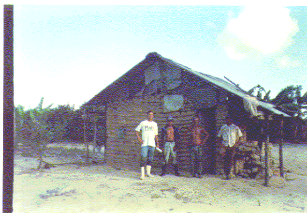
FIGURA 17 – Casa de centro com paredes de barro no Assentamento Luiz Lopes Sobrinho.
